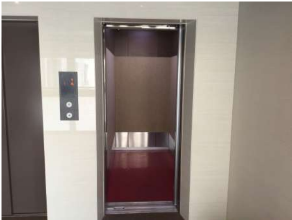
【その他共用部】エレベーター。段差が少なく奥行もあり、車いすの乗降がしやすい
