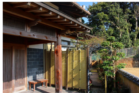
【外観写真】玄関付近外観
