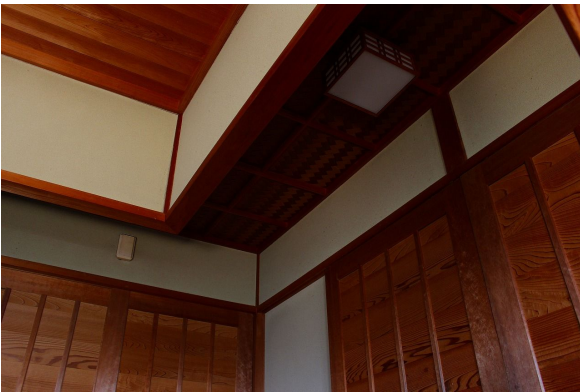
【居間・リビング】居間部分の天井の造り
