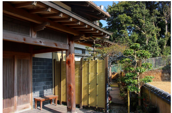
【外観写真】玄関付近外観
