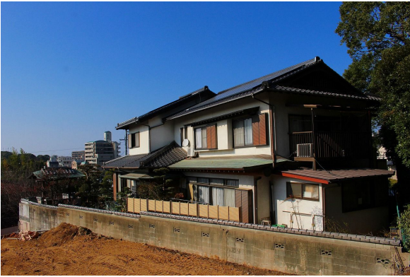
【外観写真】高台に位置していますので眺望良好です
