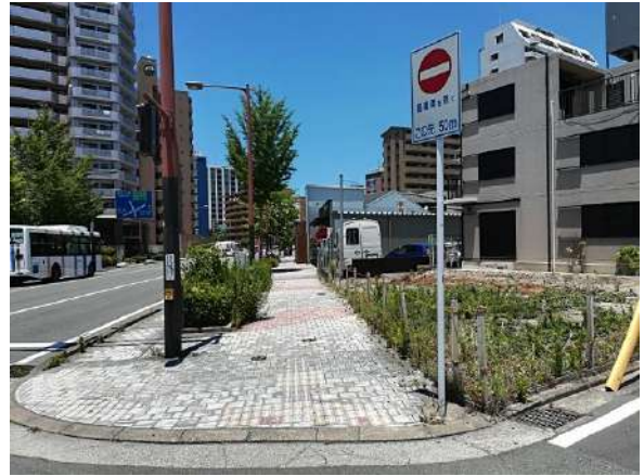
【前面道路合む現地写真】
