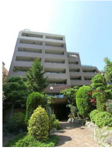
【外観写真】外観写真
