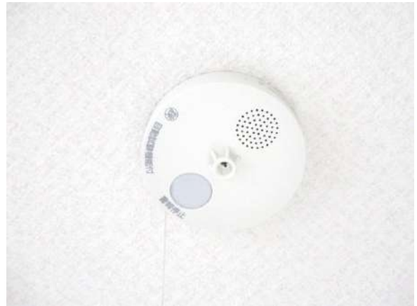
【同仕様写真(内観)】全居室に火災警報器を新設予定。キッチン熱式、その他煙式です。
