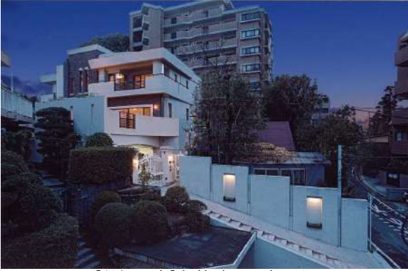
【外観写真】新築時の写真です。
