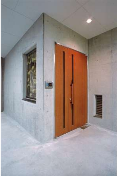
【その他設備】新築時の写真です。地下玄関です。
