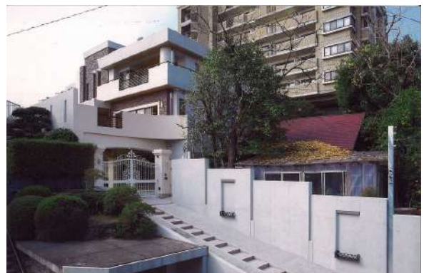
【外観写真】新築時の写真です。
