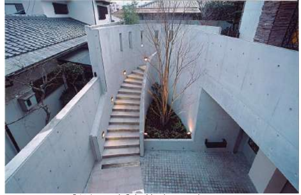
【外観写真】新築時の写真です。
