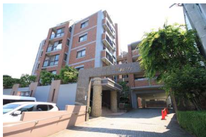
[外観・現況][外観写真]
