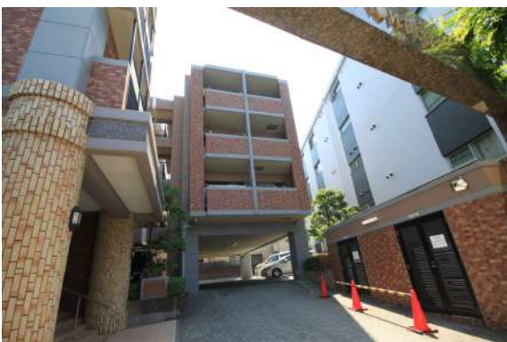
[外観・現況][外観写真]
