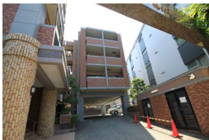
[外観・現況][外観写真]
