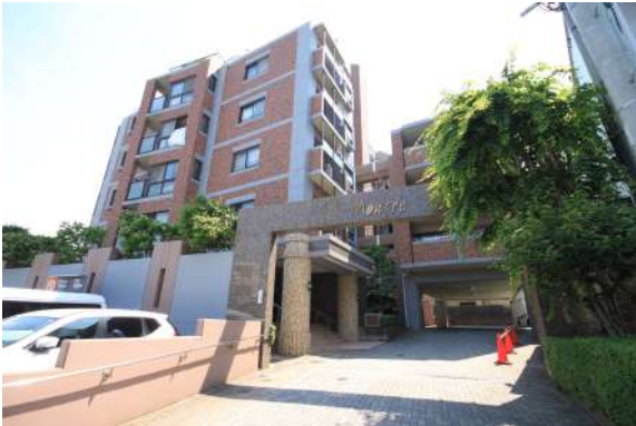
[外観・現況][外観写真]
