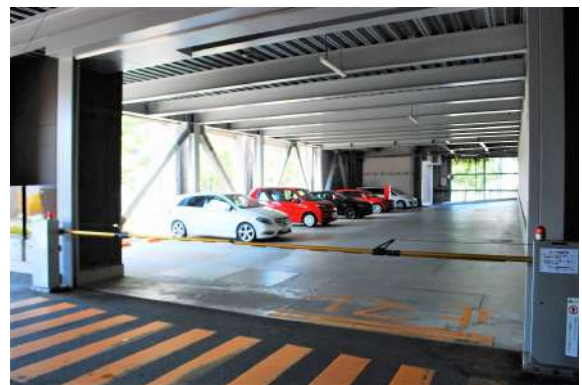
[共用部・設備施設][駐車場]
