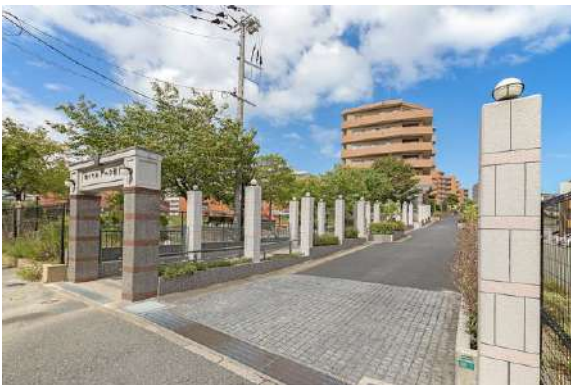
[外観・現況][エントランス(外)]アプローチ
