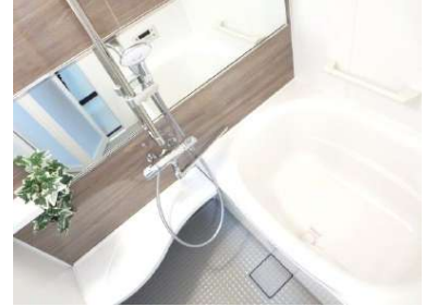
浴室はリクシル製ユニットバスに新品交換しました。
