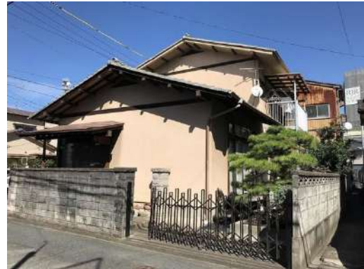
[外観・現況][外観写真]西側
