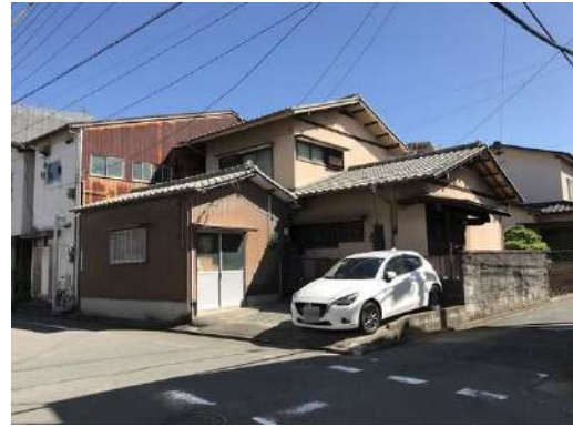
[外観・現況][外観写真]外観写真
