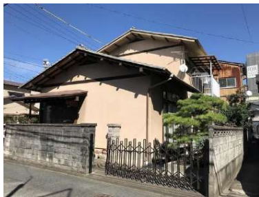
[外観・現況][外観写真]西側
