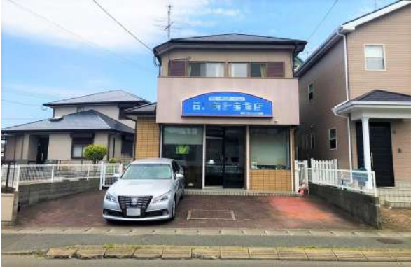
[外観・現況][現況外観写真]
