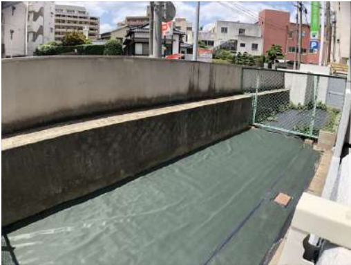
[専用部・室内写真][バルコニー]【専用庭 (防草シート完了)】
