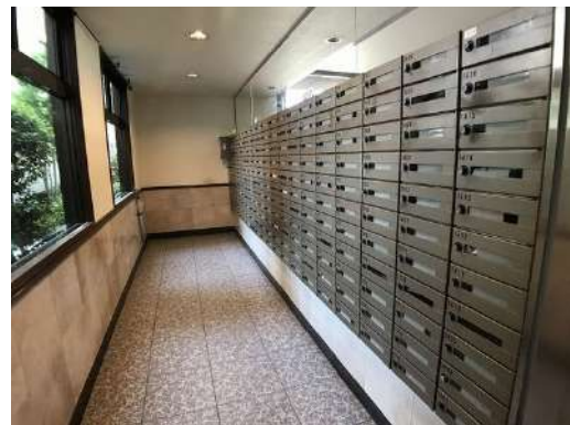
[共用部・設備施設][郵便受け]メールボックス
