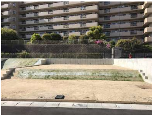
[外観・現況][現況写真]
