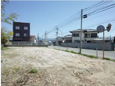
[外観・現況][現況写真]北西方向から撮影。
