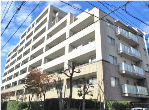
[外観・現況][外観写真]
