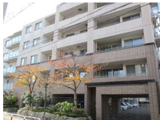
[共用部・設備施設][駐車場]車両出入り玄関 (シャッターゲート)
