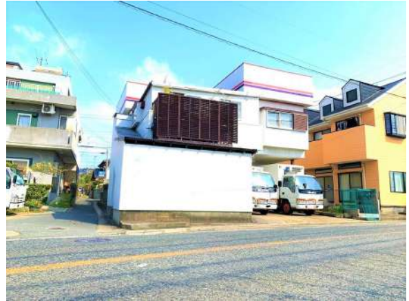
【現況外観写真】
