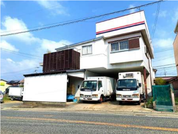
【現況外観写真】
