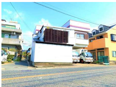
【現況外観写真】
