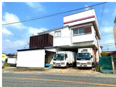
【現況外観写真】
