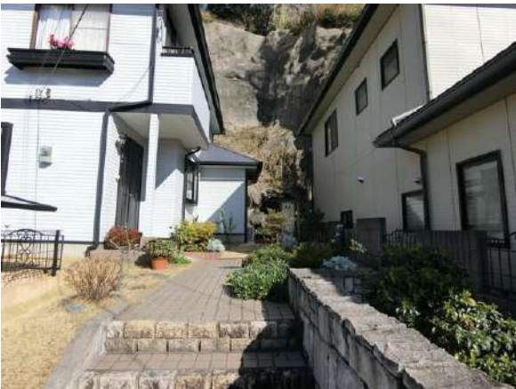
【外観写真】スロープ付きアプローチ
