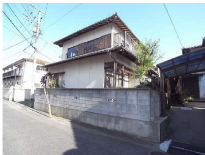
【前面道路含む現地写真】
