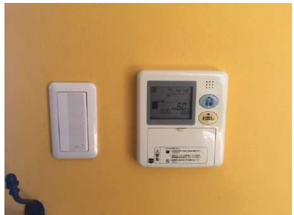
【発電・温水設備】
