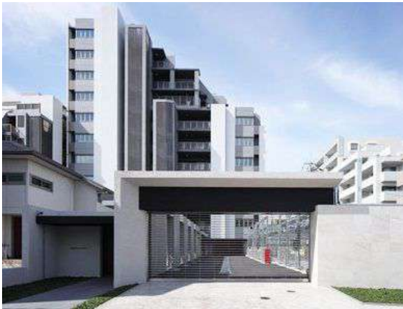
【外観写真】クールな外観！
