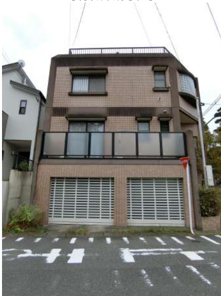
【現況外観写真】
