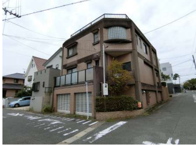
【現況外観写真】
