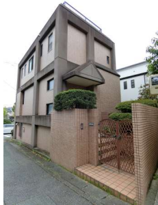
【現況外観写真】
