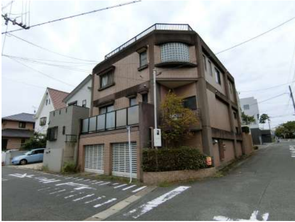
【現況外観写真】
