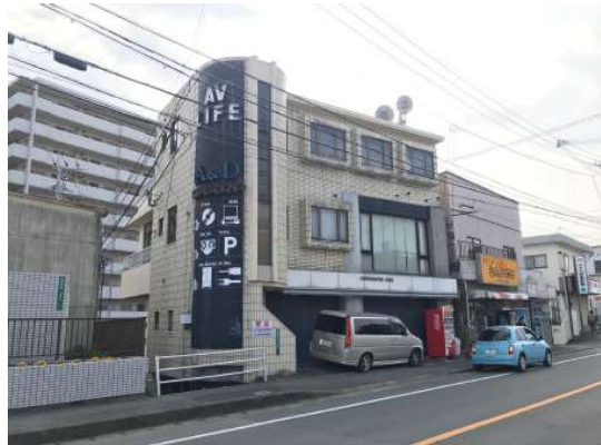
【現況外観写真】
