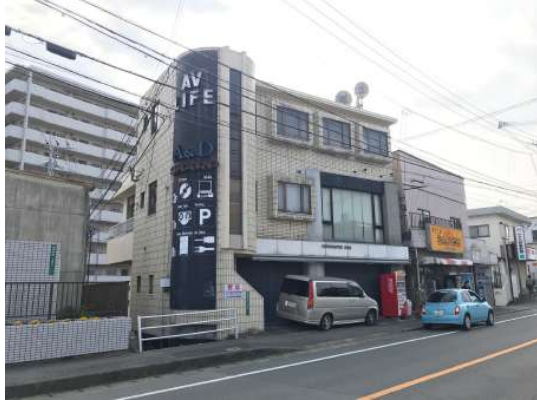
【現況外観写真】
