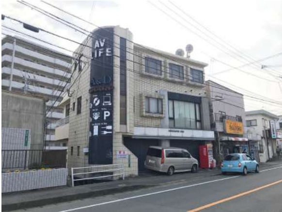
【現況外観写真】
