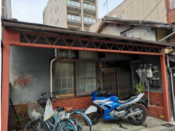
【現況写真】現況
