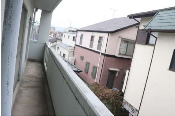
【バルコニー】3階バルコニー
