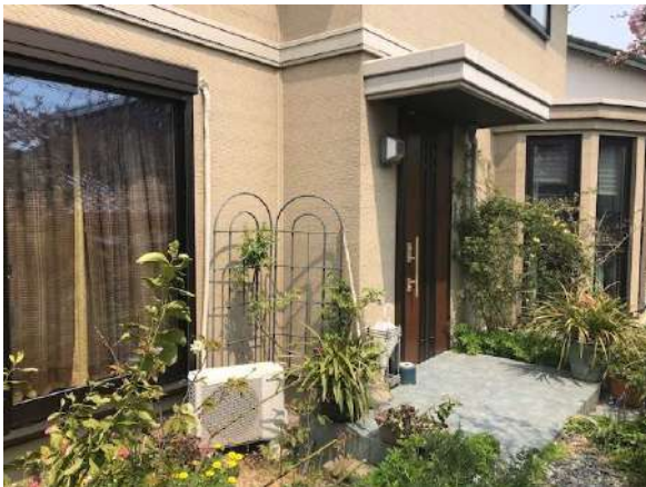
【現況外観写真】
