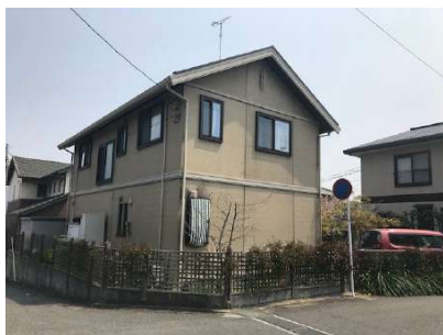
【現況外観写真】
