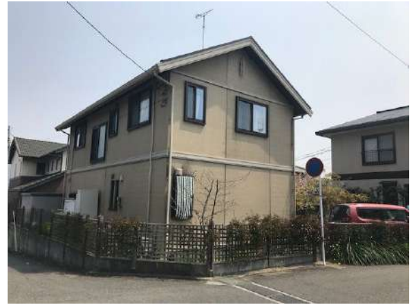
【現況外観写真】
