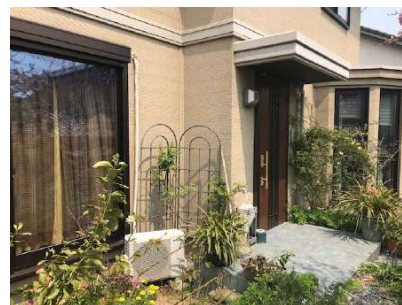
【現況外観写真】
