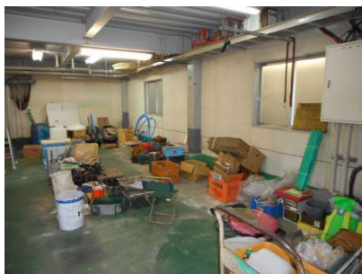
【その他設備】1階 倉庫
