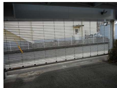
【その他設備】シャッター付き
