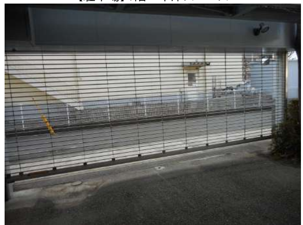
【その他設備】シャッター付き
