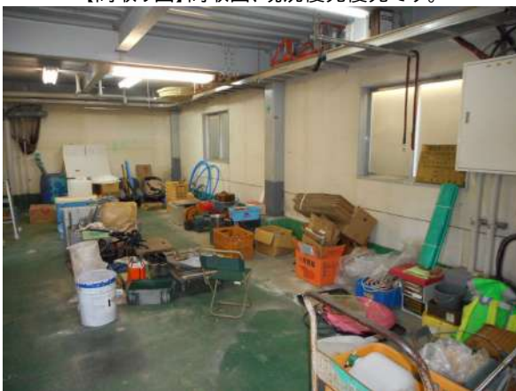
【その他設備】1階 倉庫
