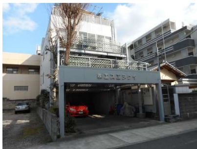
【現況外観写真】外観
