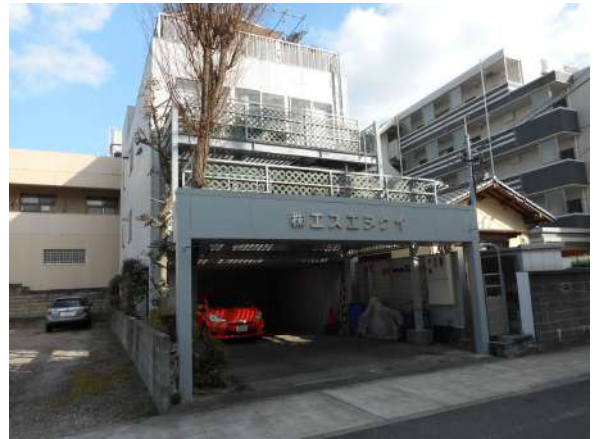
【現況外観写真】外観
