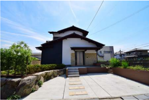
【外観写真】和風の良さを活かして、外壁塗装で生まれ変わりました! 駐車 2
