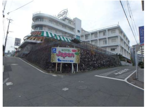
【前面道路含む現地写真】
