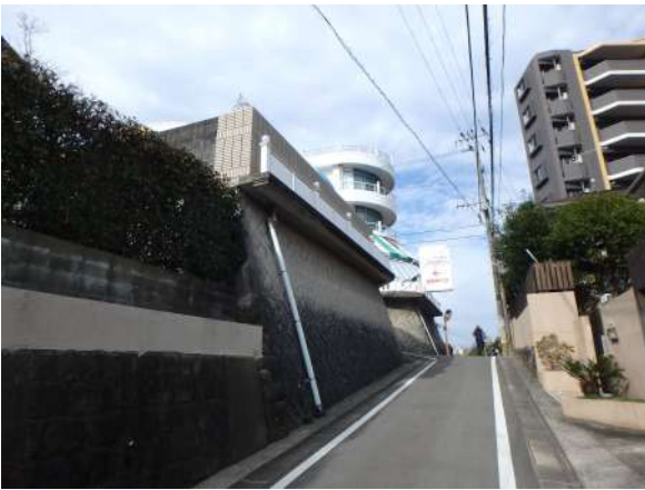
【前面道路含む現地写真】
