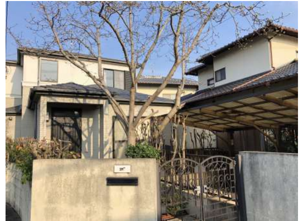
正面からの外観写真です。
