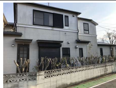
建物北側の写真です。
