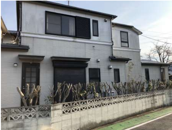
建物北側の写真です。
