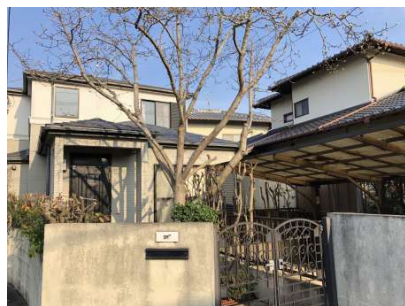
正面からの外観写真です。
