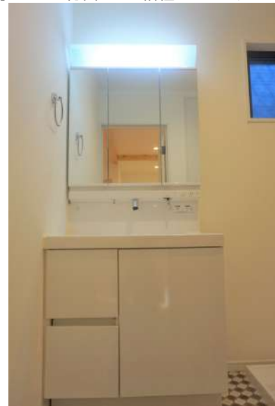
【洗面化粧台】洗面脱衣所に窓有!湿度が上がる場所には換気が大事です♪
