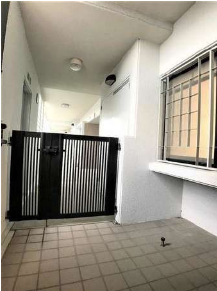
【玄関】玄関ポーチあり
