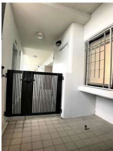
【玄関】玄関ポーチあり
