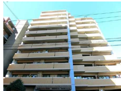
【外観写真】外観写真
