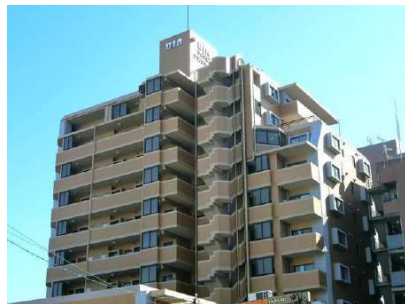
【外観写真】外観写真
