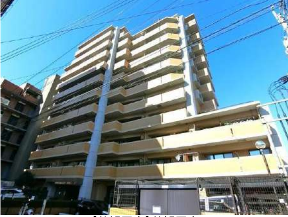
【外観写真】外観写真
