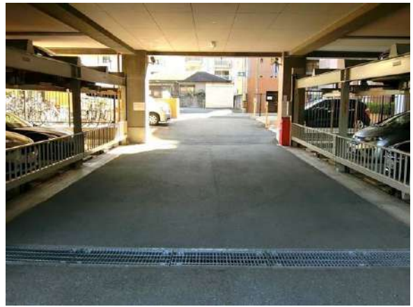
【敷地内駐車場】機械式駐車場
