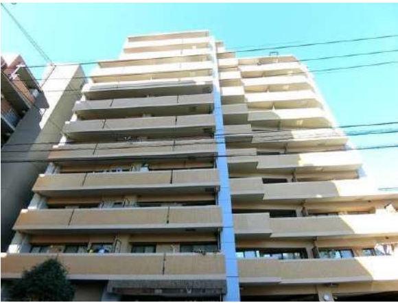
【外観写真】外観写真
