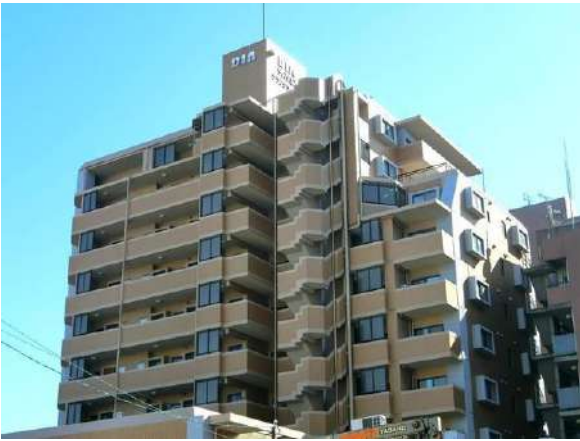
【外観写真】外観写真
