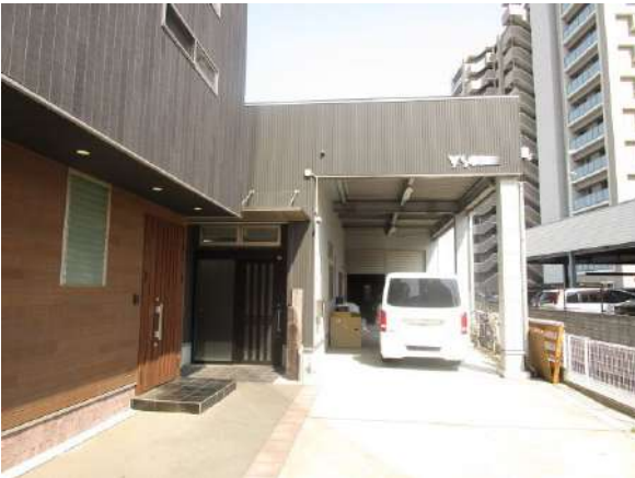
【外観写真】倉庫付き事務所は3階建てです
