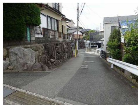
【前面道路含む現地写真】
