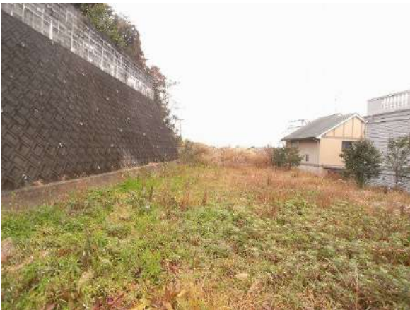
【現況写真】宅地
