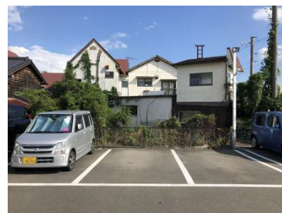
【現況写真】北側隣地から物件を望む
