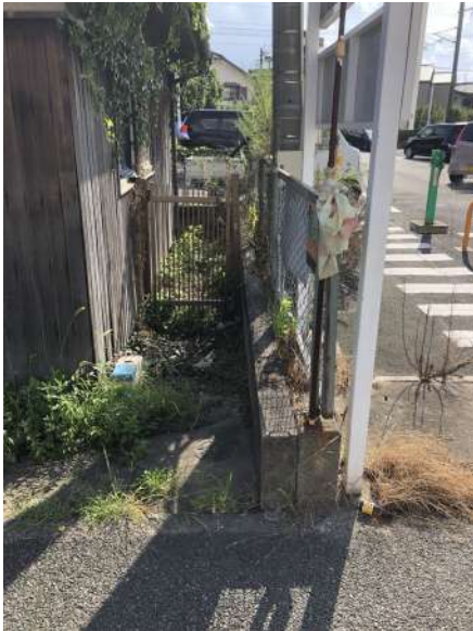
【現況写真】北側隣地および道路との境界付近
