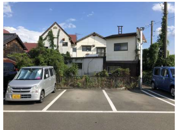
【現況写真】北側隣地から物件を望む
