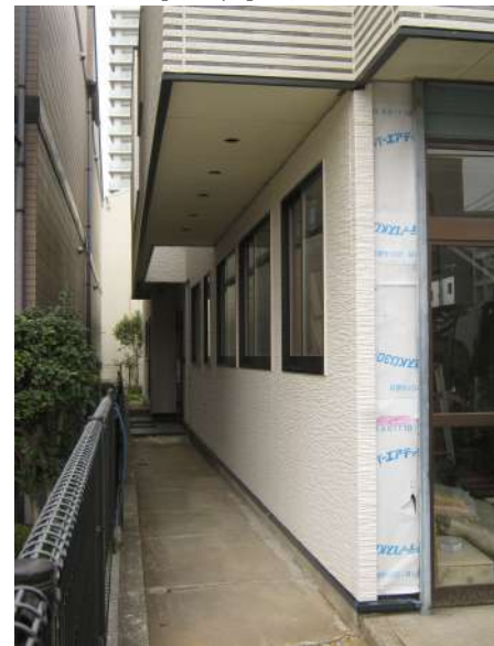
【現況外観写真】
