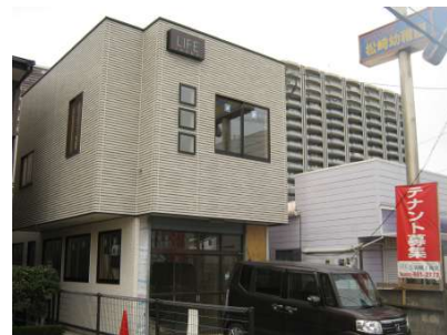
【現況外観写真】
