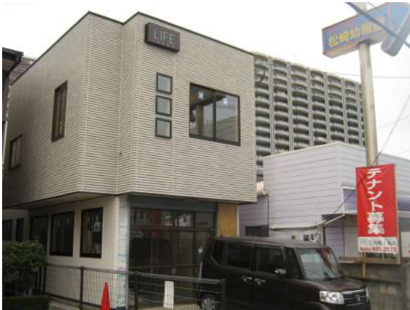
【現況外観写真】
