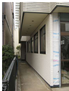
【現況外観写真】
