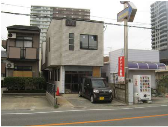
【現況外観写真】
