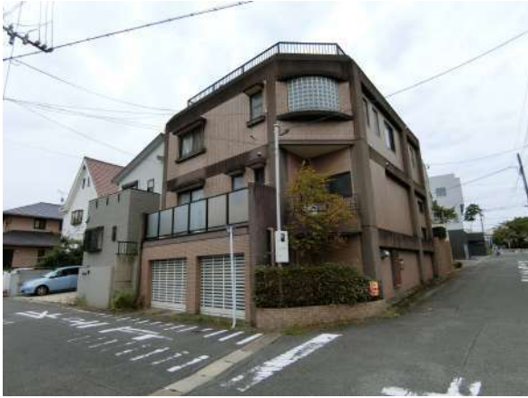
【現況外観写真】
