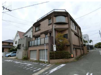
【現況外観写真】
