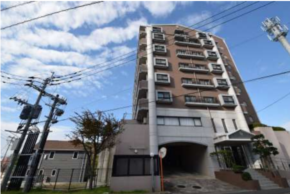
【外観写真】地上6階 地下2階建ての1階部分のお部屋です。
