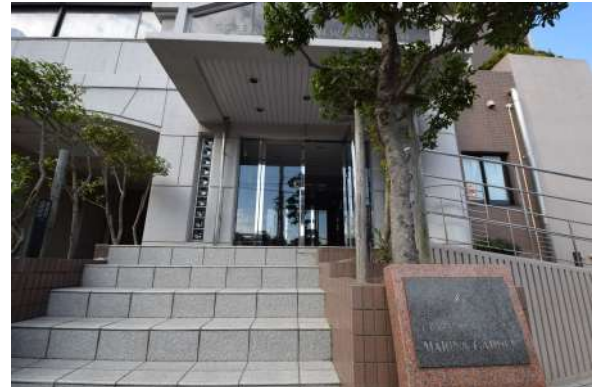
【その他共用部】エントランス
