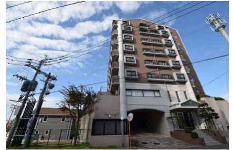
【外観写真】地上6階 地下2階建ての1階部分のお部屋です。
