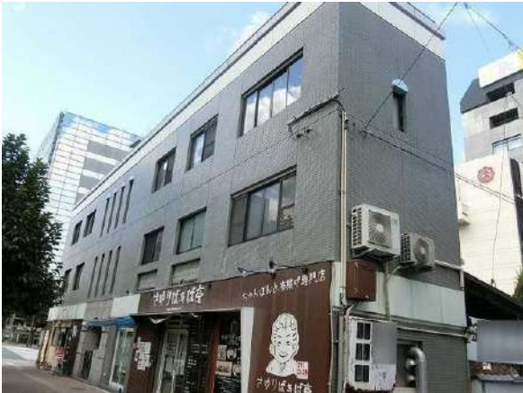
【外観写真】外観写真
