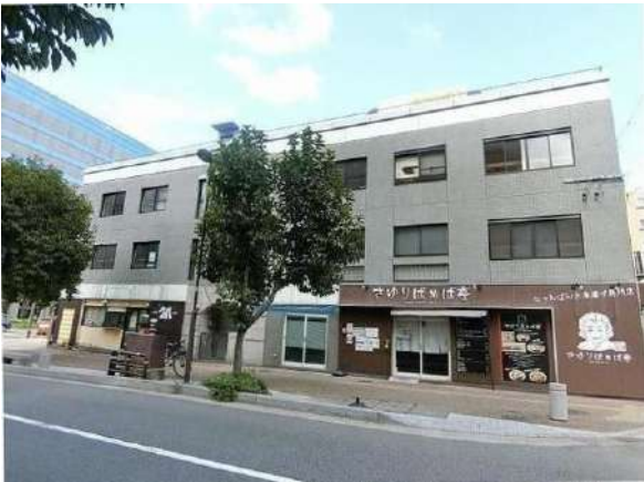
【外観写真】外観写真
