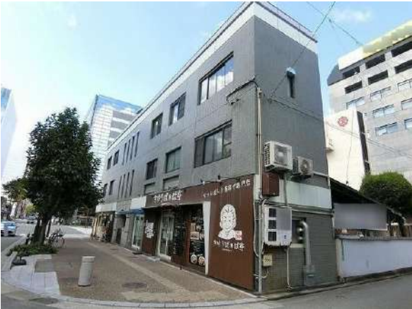
【外観写真】外観写真
