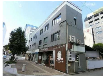
【外観写真】外観写真
