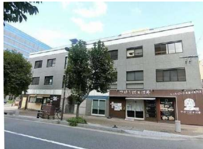
【外観写真】外観写真
