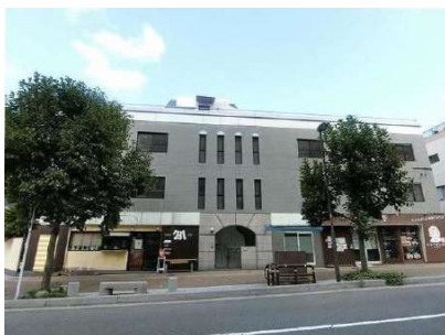
【外観写真】外観写真
