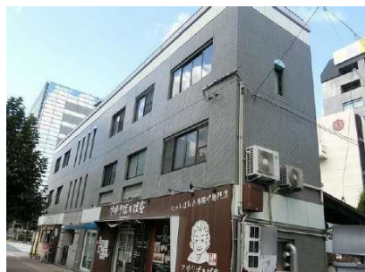
【外観写真】外観写真
