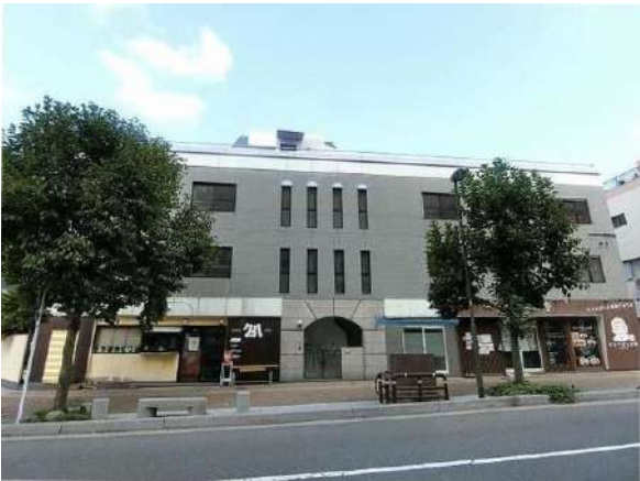
【外観写真】外観写真
