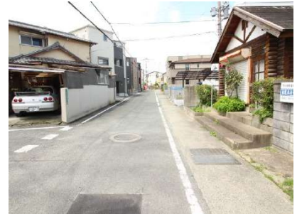
【前面道路含む現地写真】前面道路
