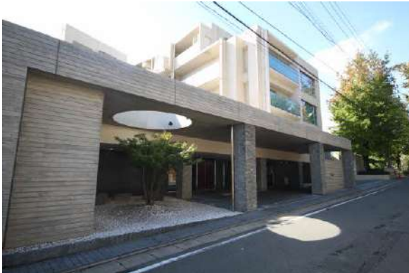
24時間監視のセキュリティシステム「ホームサット24」導入
