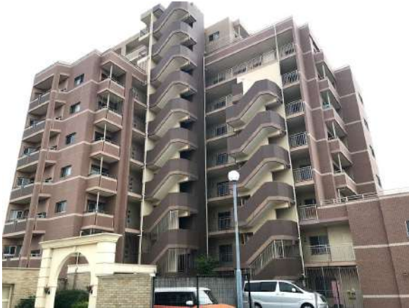
【外観写真】外観タイル貼りのマンション
