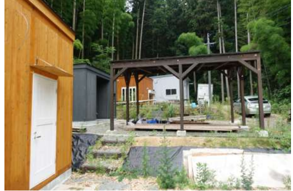
【現況外観写真】
