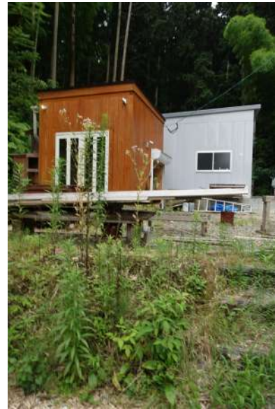
【現況外観写真】
