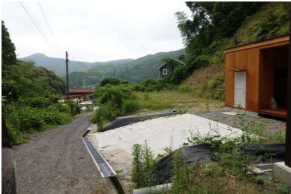
【現況外観写真】
