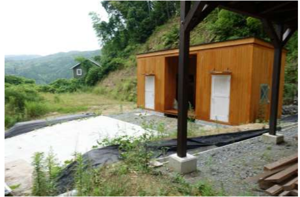
【現況外観写真】
