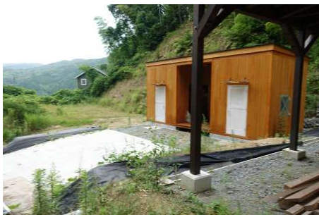
【現況外観写真】
