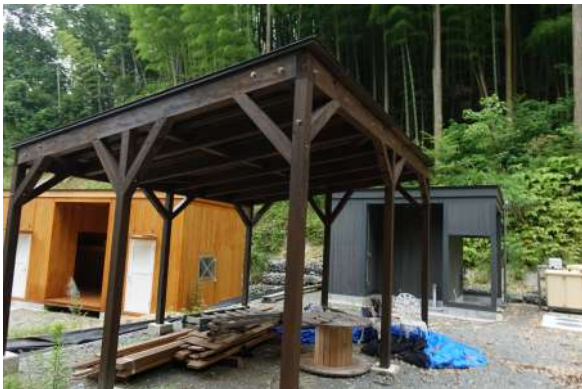
【現況外観写真】
