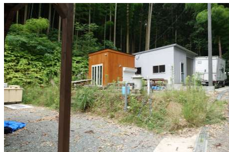
【現況外観写真】
