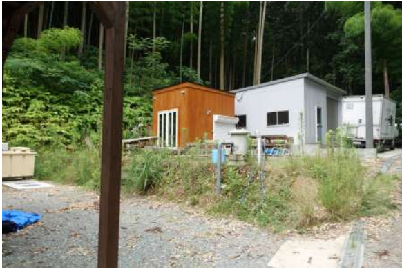
【現況外観写真】
