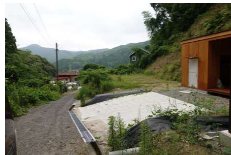
【現況外観写真】
