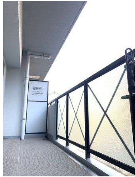
幅の広いバルコニーです。
