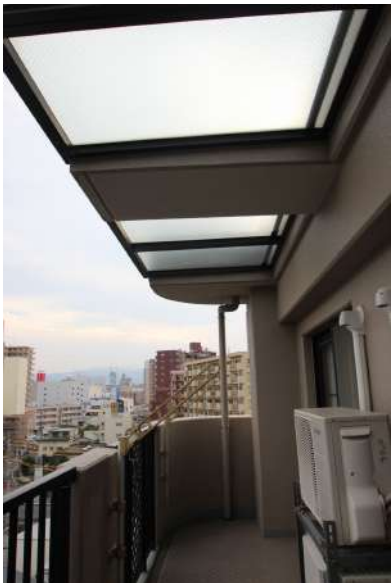
【バルコニー】南東方向バルコニーは、テラスタイプで急な雨でも安心です
