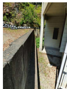
【その他】北東側隣地高低差
